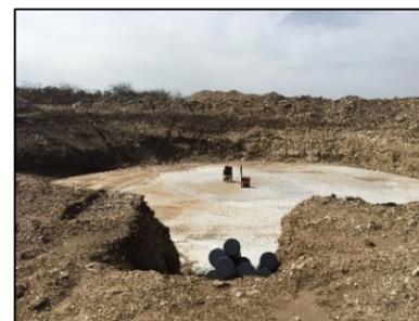
**Excavation et béton de propreté**
